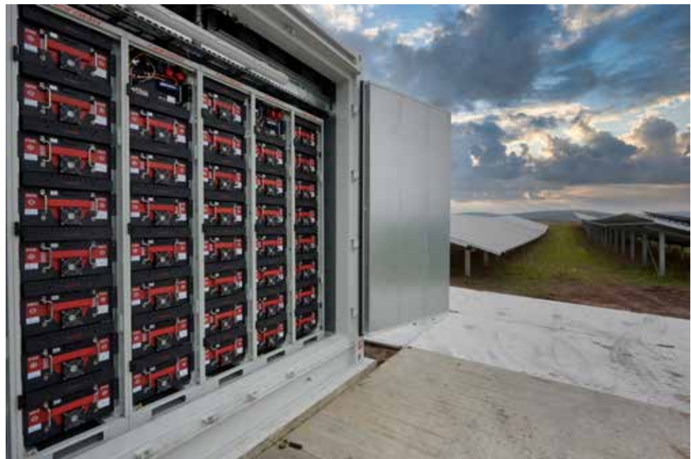
▲ Großspeicher vom Hersteller Intilion in der PV-Anlage Hühnerellern.
